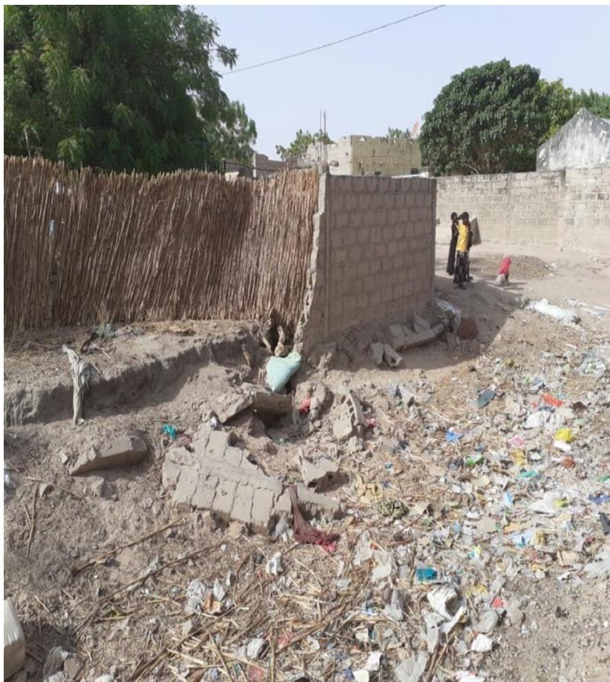
**Photo 10 :** Mur de clôture d'une concession terrassé par l'érosion hydrique au sein du village de Pané Abdou Diop
