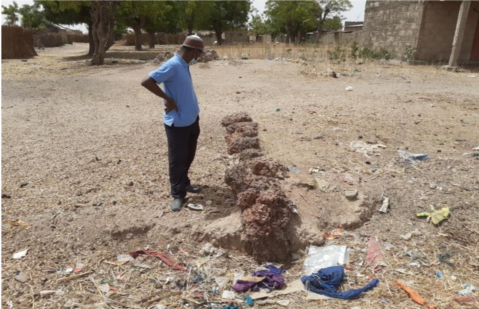
**Photo 15** : Sacs de sable utilisés pour protéger la fondation d'une salle de classe contre l'érosion
