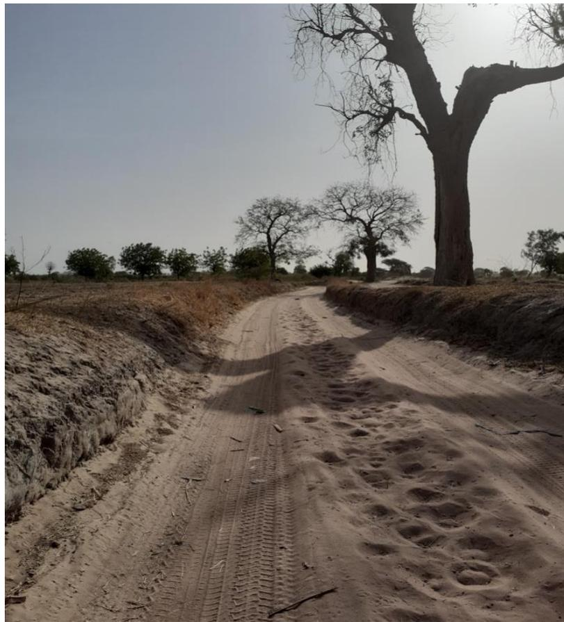
**Photo 9 :** Piste endommagée par les eaux de ruissellements au niveau du village Pané Abdou Diop
