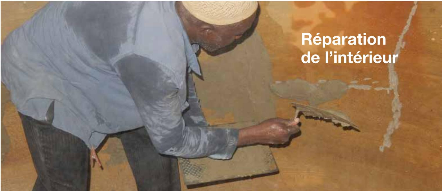
Réparez toujours les fuites et les fissure de l'intérieur. Alors la citerne est vide. Entrez-y et nettoyez la surface avec une brosse en acier, rendez la surface soigneusement rugueuse avec un burin et un marteau et mouillez-la ensuite de sorte que le nouveau plâtre puisse bien adhérer au mur. Utilisez un mélange de ciment, de sable et d'eau bien consistant et pas trop humide. Gardez la réparation humide pendant une semaine en utilisant un sac ou un chiffon régulièrement mouillé.
