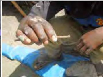
Contrôlez l'épaisseur du plâtre à l'aide d'un bâtonnet
