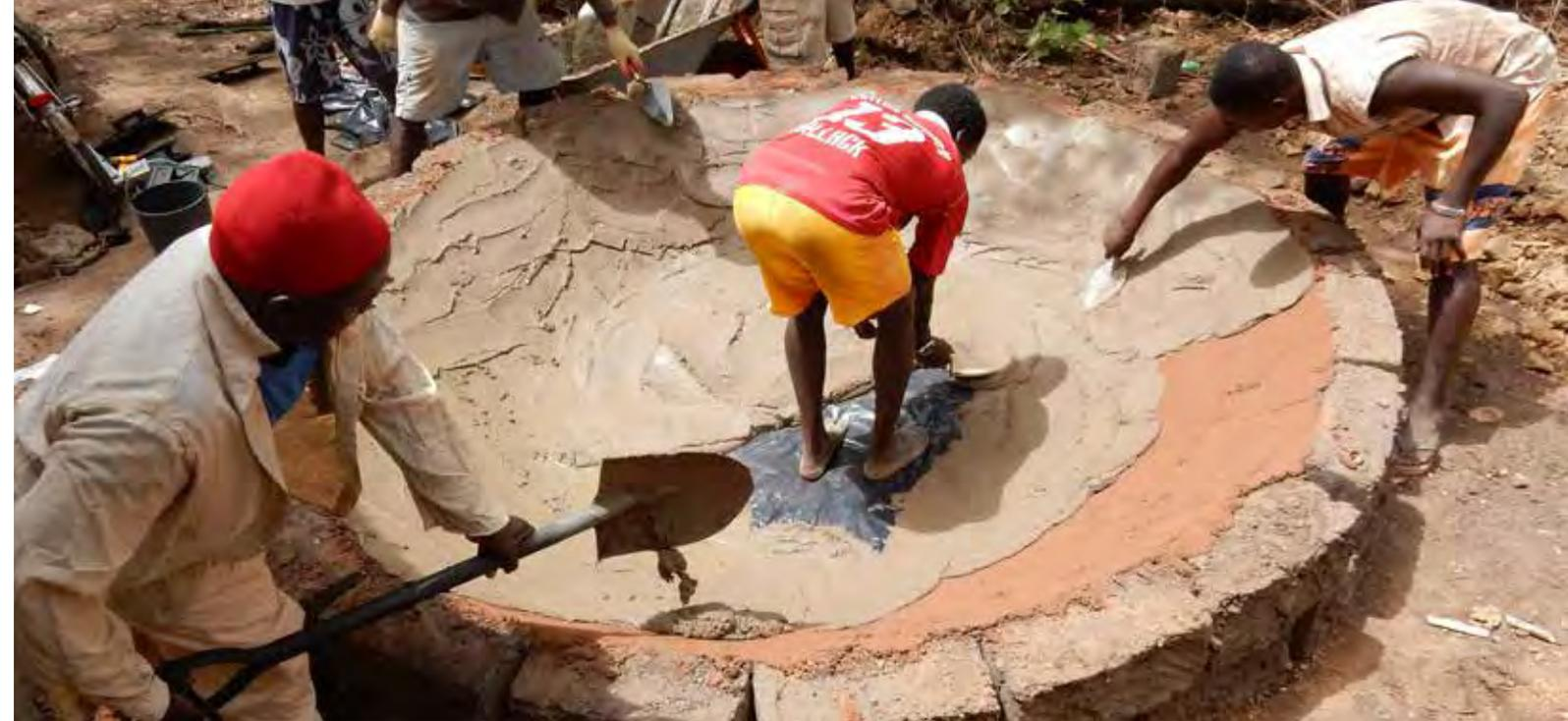
La construction du sol se fait en **3 couches**: ① mortier (1er sac de ciment) ② filet de poulet ③ mortier (2me sac de ciment). Le mortier repose sur le sable mouillé ou sur la feuille de plastique pour éviter qu'il ne dessèche.
