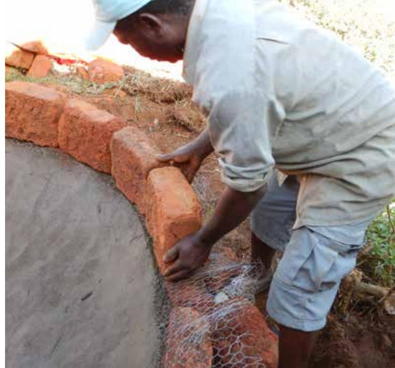
Pliez le filet de poulet sur les blocs et empilez la rangée suivante de blocs Dessus.
