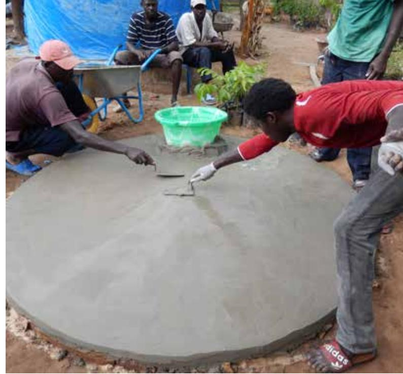
En haut: le toit est renforcé de fil d'acier torsadé en 3 ou 4 cercles. En bas: le couvercle doit s'adapter exactement sur le trou d'homme pour garantir l'obscurité absolue à l'intérieur.
