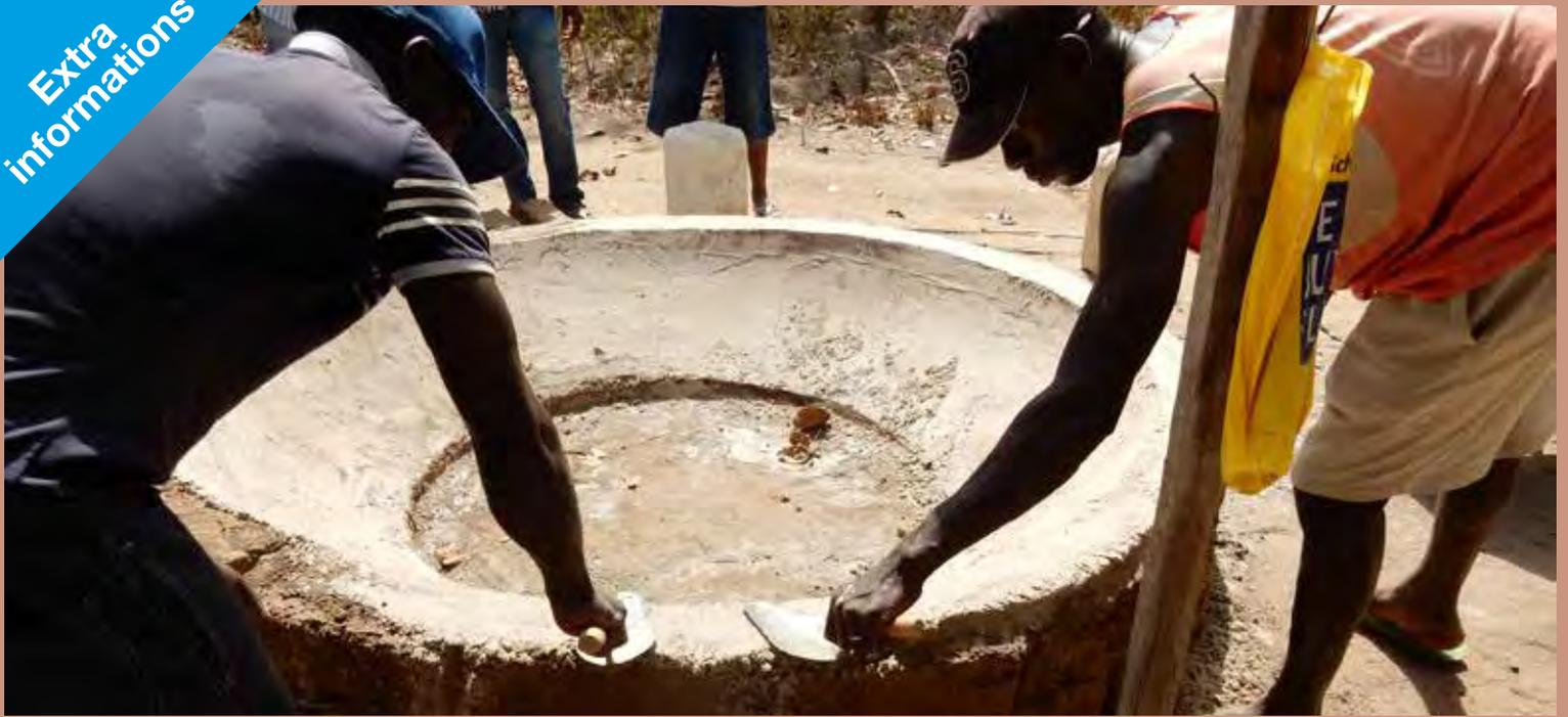
La bonne connexion entre le sol et la paroi est très importante pour la résistance et l'étanchéité de la citerne. Quand la forme ressemble au globe terrestre, au ballon de football, le pic de tension du ciment est moins intense et les risques de fissures sont moins nombreux. Vous avez déjà vu un ballon de football avec des fissures? **Pas de fissures, pas de fuites d'eau!!**
