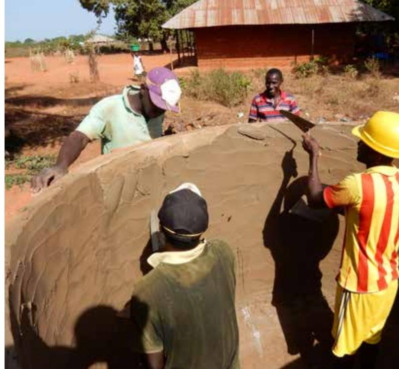
En haut: du mortier sur le sable mouillé. Le mortier est courbé sur le bord du moule.
