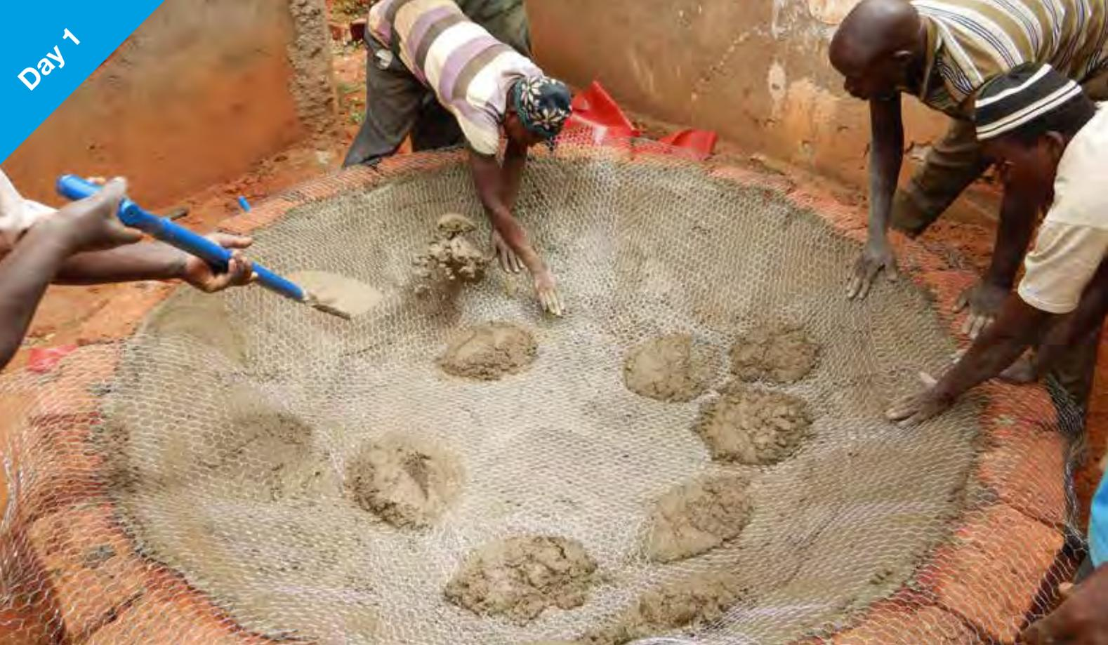
Ajustez le fil de poulet: pliez le filet à l'extérieur sur la 2ème rangée de blocs. (au lieu de le plier à l'intérieur). Le contrôle sera meilleur. C'est une bonne idée de M. Roger Mbumbu, RD du Congo.
