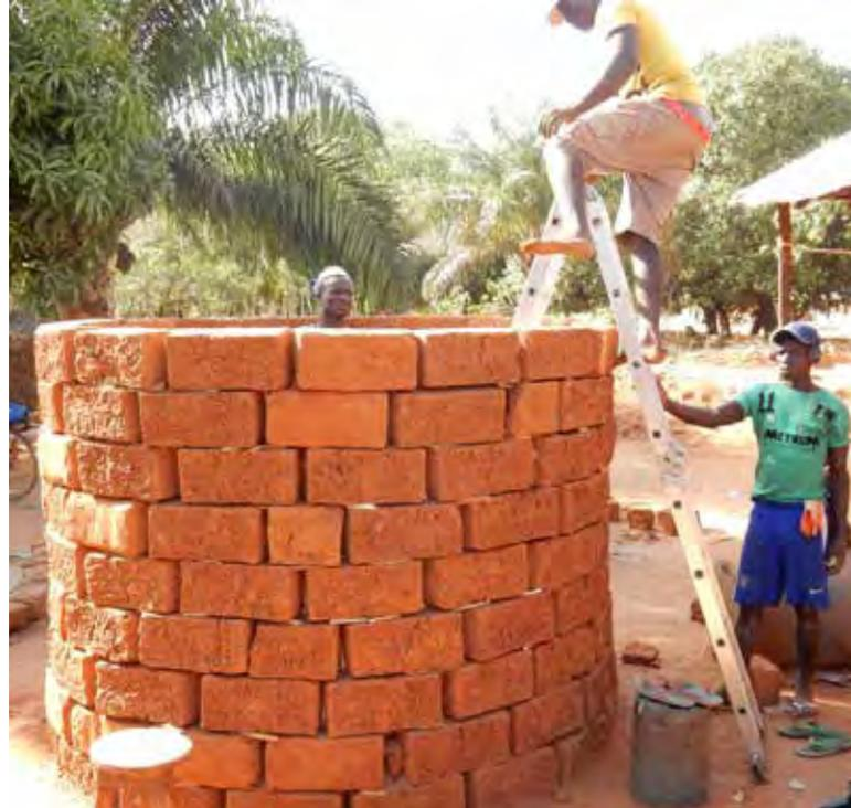
En haut: Construisez le moule avec les blocs d'argile en + de 9 rangées jusqu'à 1.70 m de haut. En bas: Appliquez une couche de sable mouillé pour rendre lisse la surface intérieure du moule. Utilisez un levier pour faire le mur vertical.
