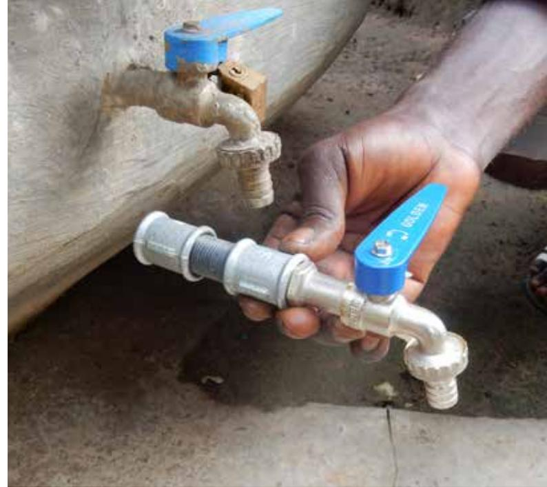
Faites soigneusement un trou dans la paroi cylindrique pour le robinet à quelques cm au-dessus du fond courbe. Utilisez un morceau de tube de PVC et de 2 raccords pour éviter les fuites d'eau. Une partie du premier raccord doit sortir du mur pour pouvoir tenir une clé à tubes lors du changement du robinet. Utilisez un robinet qui peut être verrouillé pendant la nuit.
