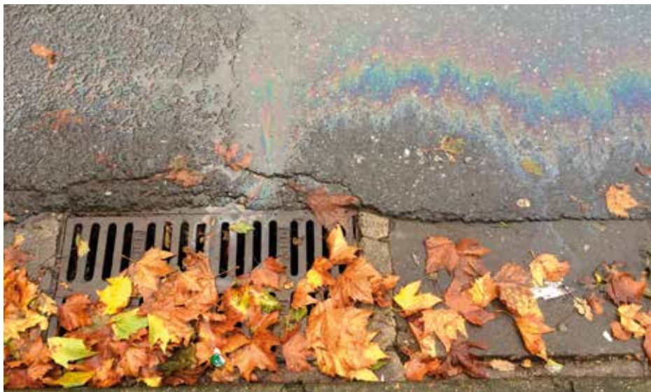
Figure 3.4 – Même dans ce genre de situation, les concentrations en hydrocarbures dans les eaux pluviales dépassent rarement 5 mg/L...
